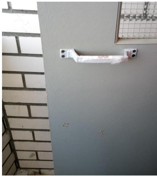
12.01.2024 На 25-м этаже замена неисправного ограничителя двери лифтового холла
